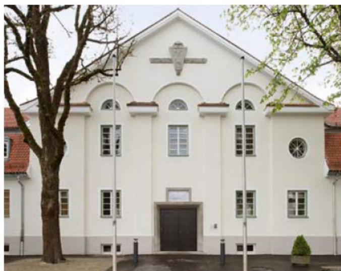
Instandsetzung der Stadthalle Penzberg (Foto: BLfD, Michael Forstner) – S. 25
