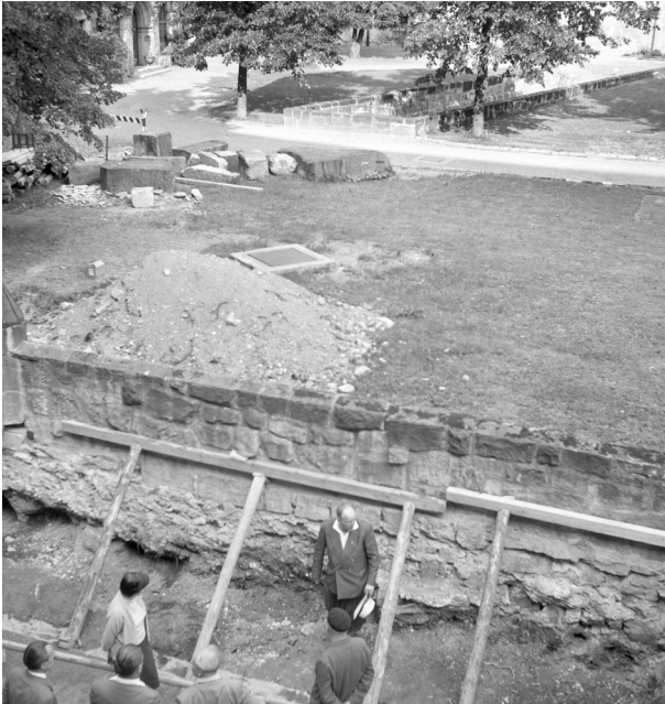
Abb. 4: Blick nach Osten über das Ausgrabungsareal von 1964. © Kunstsammlungen der Veste Coburg.
